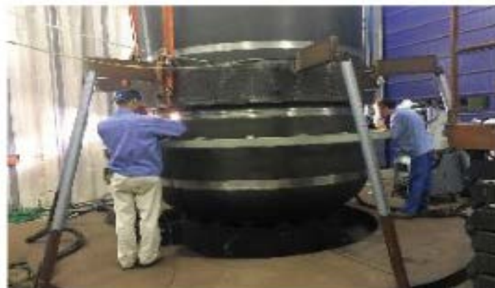
主容器环缝自动焊接技术
