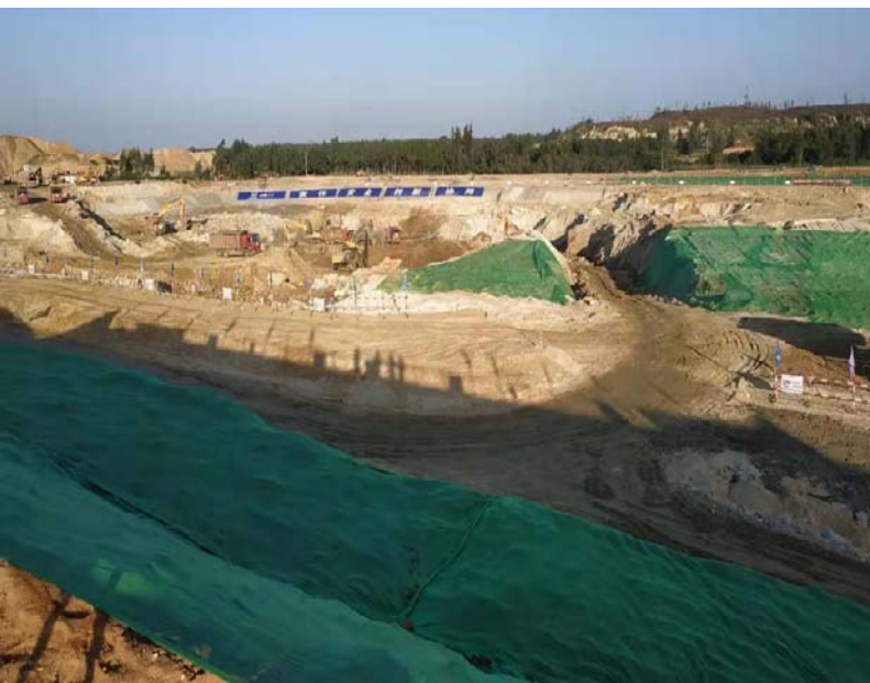
小堆施工现场
