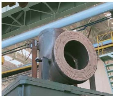
RPV主泵接管待堆焊
