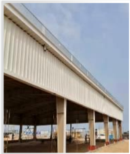
AE棚库钢结构安装 小精品工程
