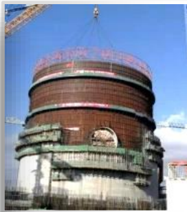
钢衬里结构全模块 化建造
