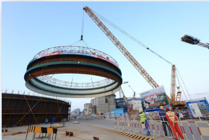
安全壳钢衬里模块化施工工艺
