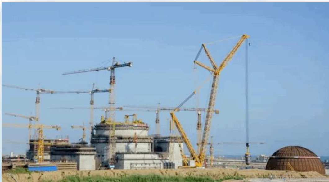
核岛开顶法施工
