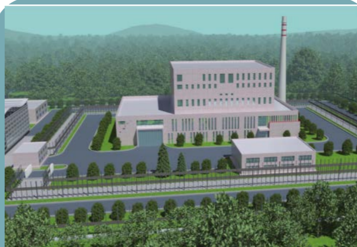
示范工程建设
