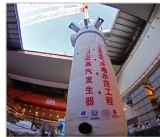
首台蒸发器吊装
