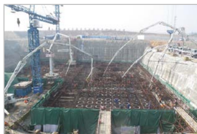
浇筑第一罐混凝土
