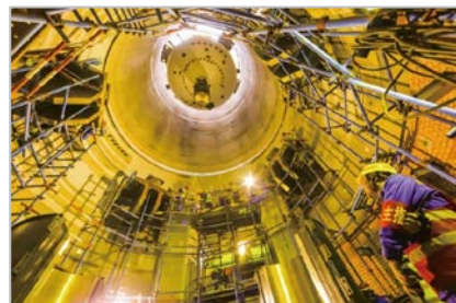
首台压力容器吊装
