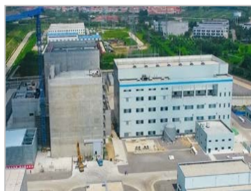
主体建筑封顶
