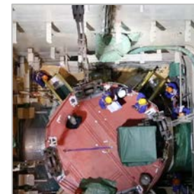
双堆三壳组对完成
